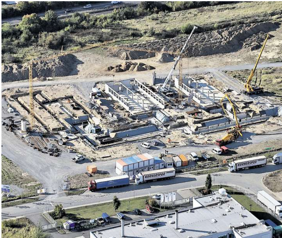
Baustelle Heinenkamp: Der Bordnetz-Spezialist Sumitomo baut für 20 Millionen Euro einen neuen Firmensitz. Im Dezember 2013 soll alles fertig sein. Fotos (3): Bertram
