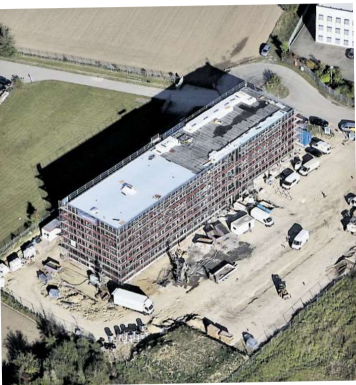
Baustelle Heinenkamp: Fahrzeug-Entwickler B&W will schon Anfang 2013 einziehen.
